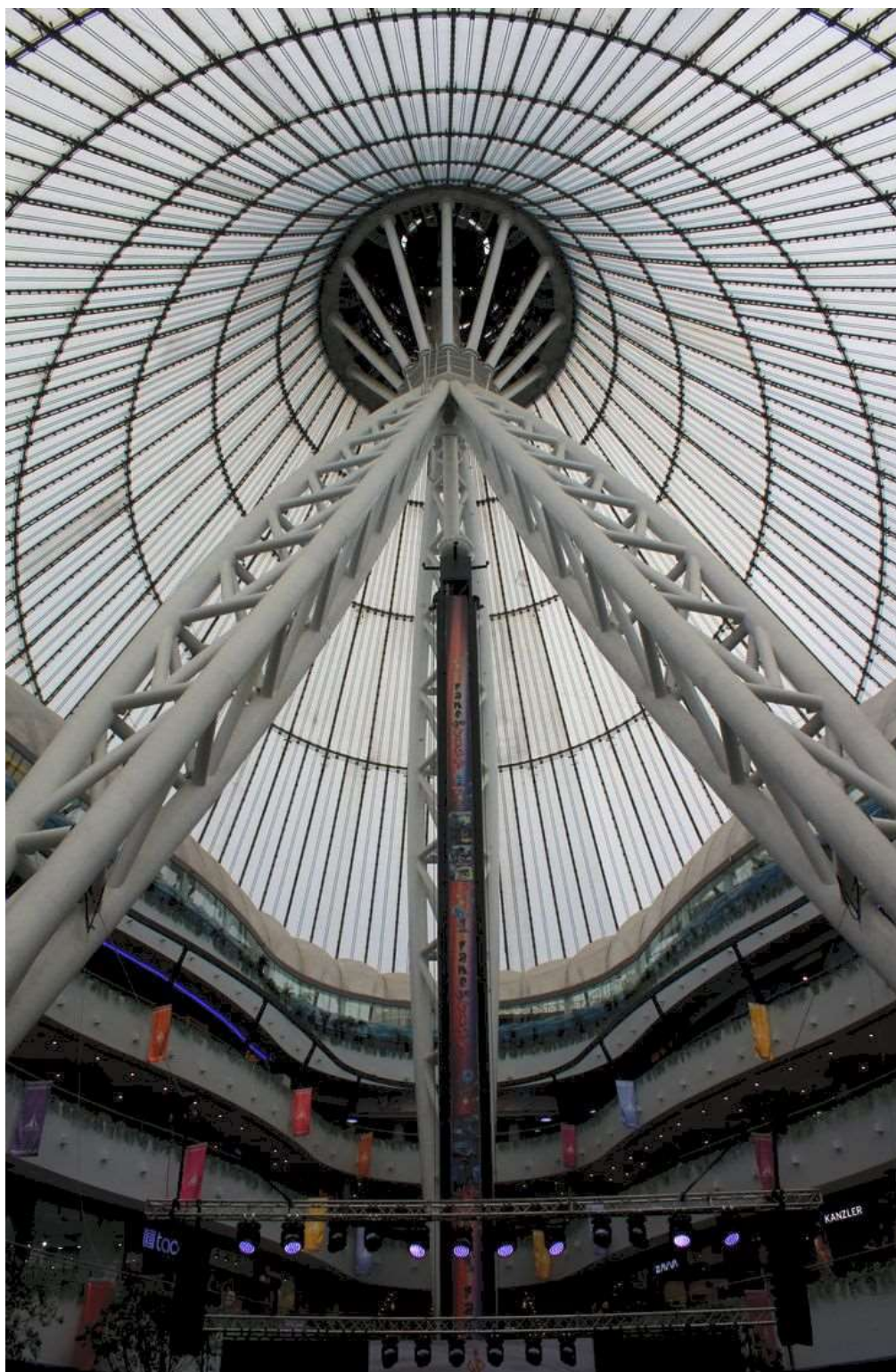
Konstrukcja podtrzymująca szklany dach
