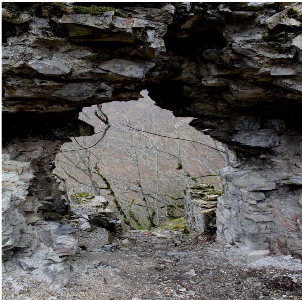
Kamienny łuk wychodzący na dramatycznie stromą i błotnistą ścieżkę
