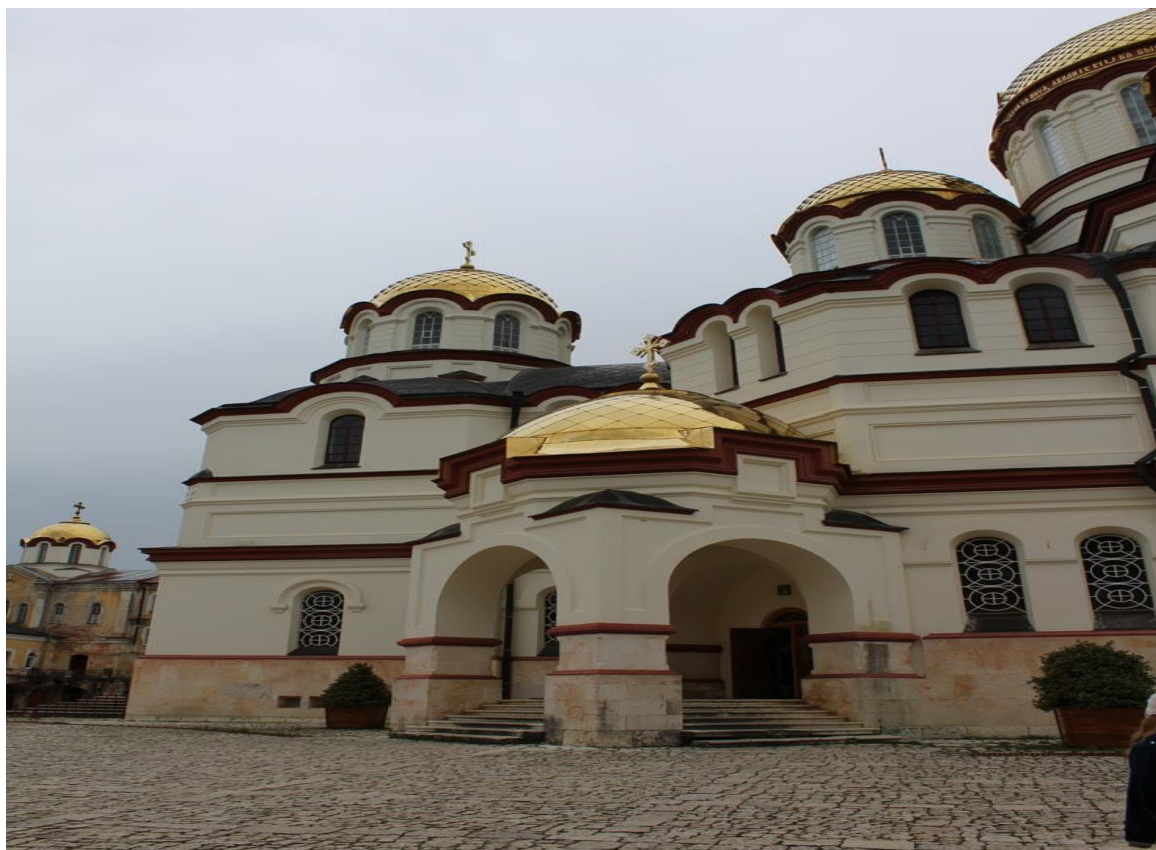
Odremontowana część kompleksu
